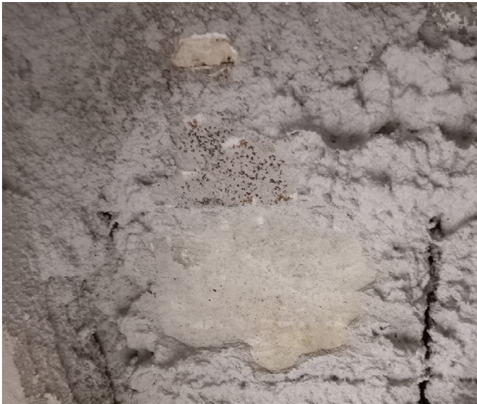
Sonda V3 – povrch očištěný pro pevnostní zkoušku + spodní pásnice ocel. nosníku
