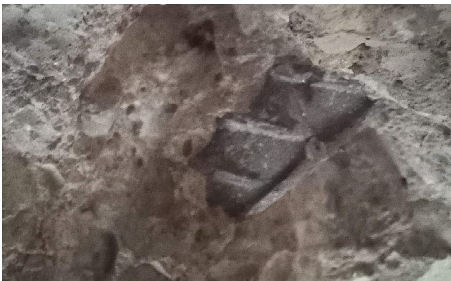
Sonda V1 – detail podélné výztuže
