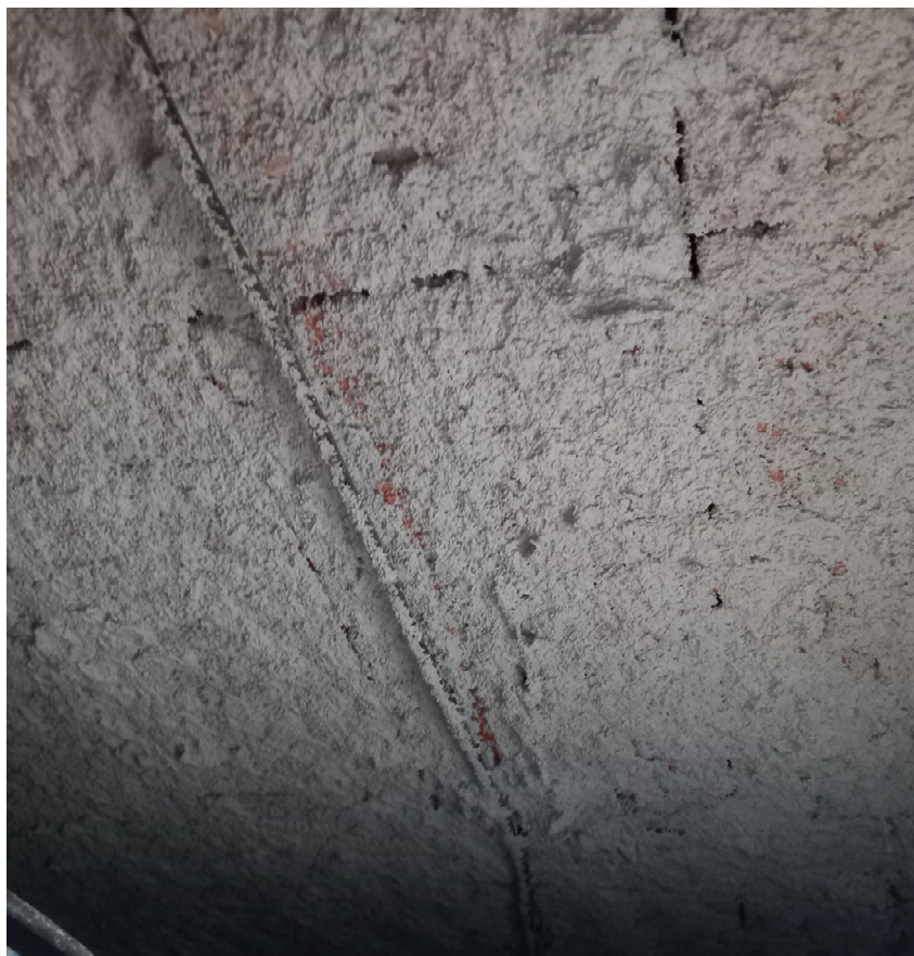
Sonda V4 – Stanovení roztečí nosníků skládaného keramického stropu
